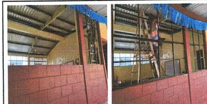
Foto 6: Trabajos de cambio de ventanas fijas con plástico por ventanas corredizas con vidrio.
